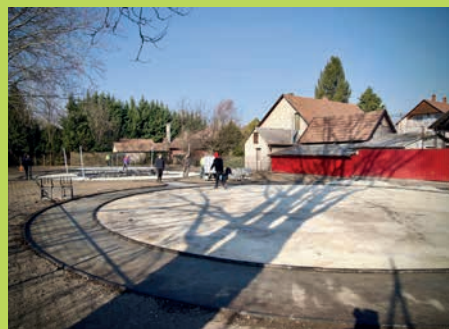
A Napsugár óvoda FELÚJÍTÁSA
