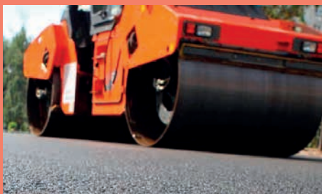
NAGY ÚTFELÚJÍTÁS Megújul több útburkolat
