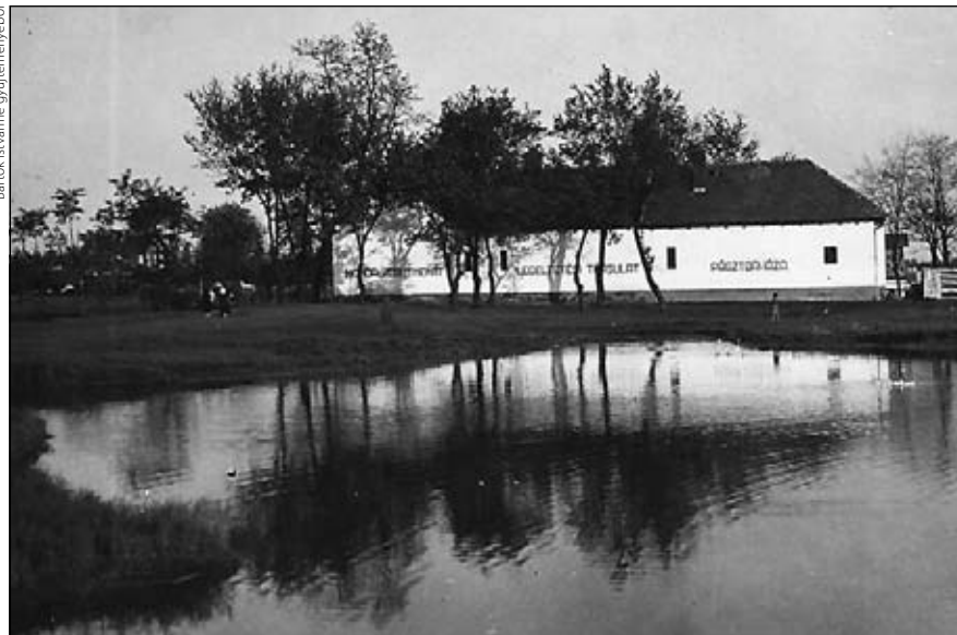
A vasút menti csordaház (pásztorház), 1935
