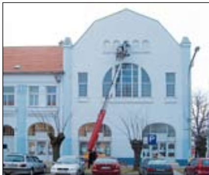
A Vigadó homlokzata szerelés közben
