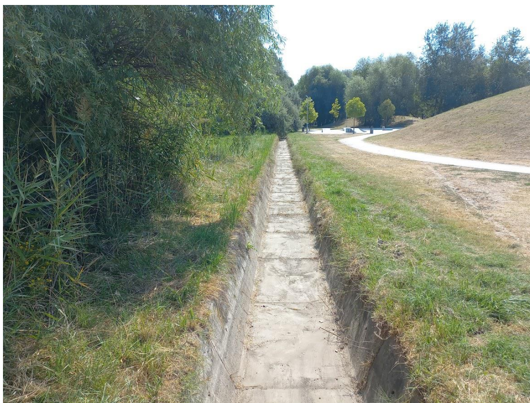
59. ábra: Csapadékvizek bevezetésére szolgáló burkolt árok (kép forrása: saját fotó 2024. augusztus)
