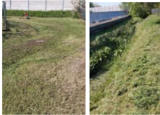
Móricz Zs. utcai átemelő melletti csatorna kaszálása
