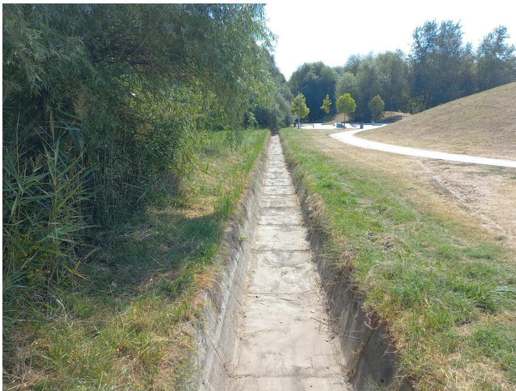
59. ábra: Csapadékvizek bevezetésére szolgáló burkolt árok (kép forrása: saját fotó 2024. augusztus)
