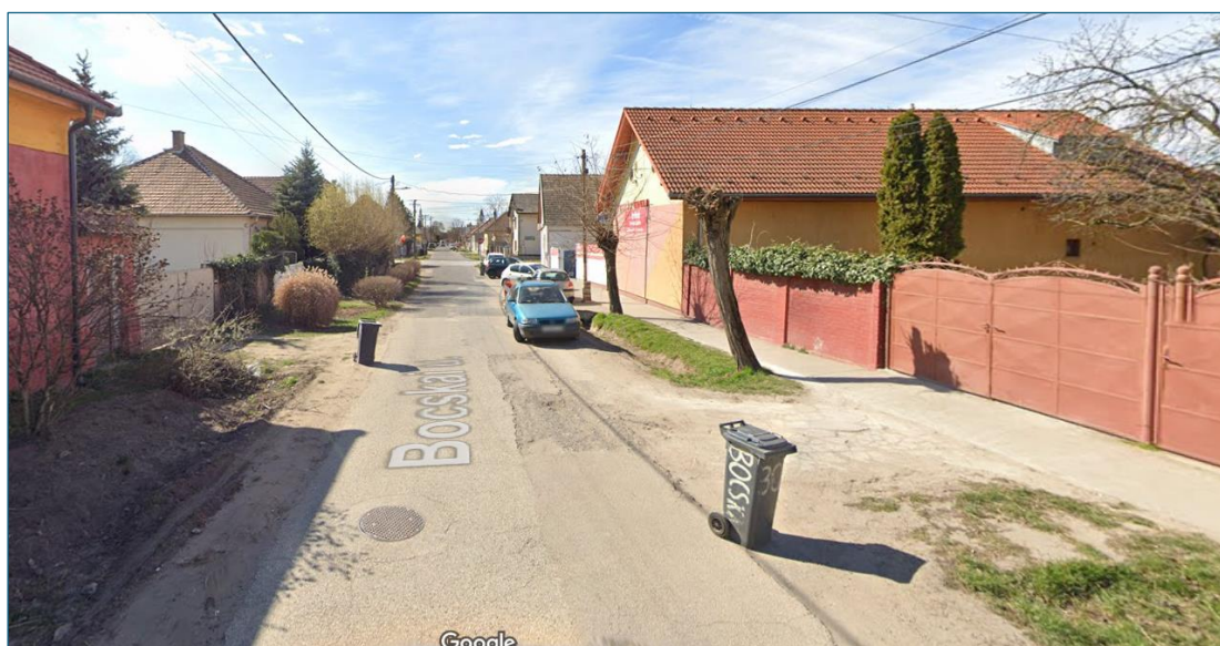
24. ábra: Eltömődékelt áteres, feltöltött földmedrű árok a Bocskai utcában (utcára kivezetett eresz) (forrás: Google maps)
