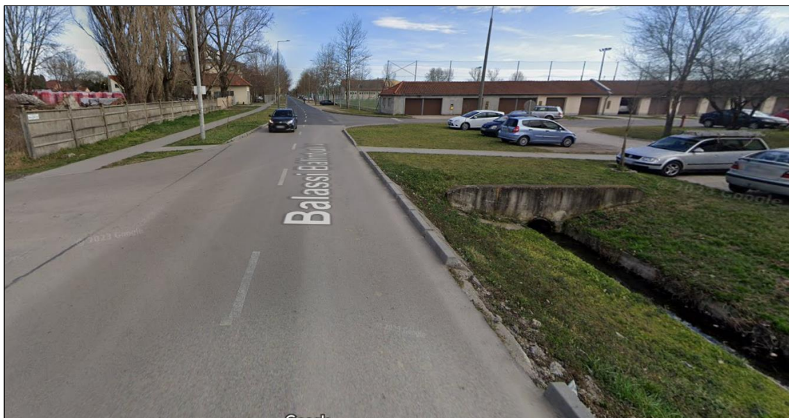
25. ábra: Nyílt, burkolt csatorna és zárt elvezető rendszer találkozási pontja a Balassa B. utcában
