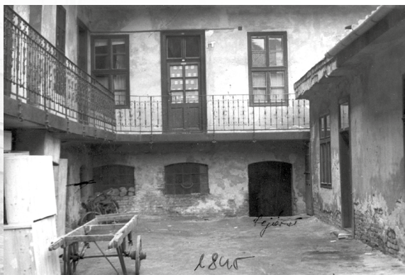
A Vajdahunyd utcai ház udvara
